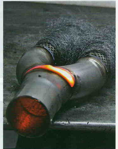
Die zuvor nur mit einigen Punkten fixierten Rohre werden jetzt sauber durchgeschweißt, um so eine Naht hinzubekommen, braucht es einiges an Übung.
