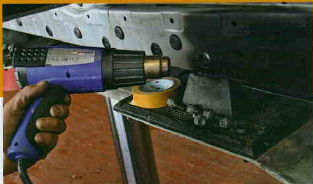
Aus optischen Gründen wird im Bereich des späteren Lufteinlasses der dahinter liegende Schweller mattschwarz lackiert.
