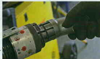
Mit einem Spezialwerkzeug werden die Rohrbögen an den Stellen aufgeweitet, an denen sie später mit anderen Elementen verbunden werden.
